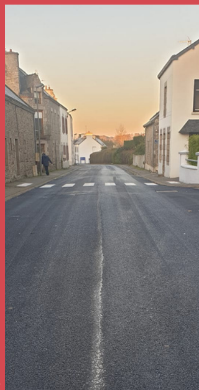
Enrobé Rue de la Fontaine ▶
